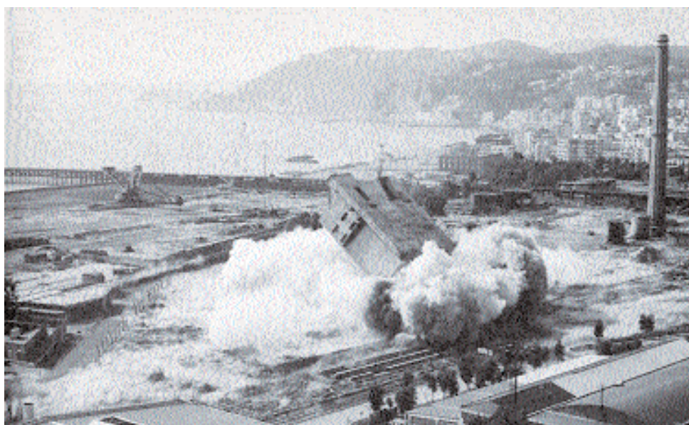
La demolizione dell'impianto Italsider a Bagnoli alla fine degli anni '90 (Archivio Ilva, Bagnoli).
